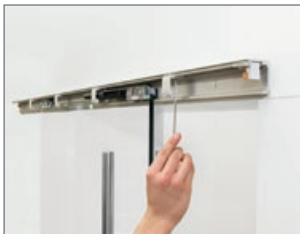
4. Montaż uchwytnych maskownic tym samym kluczem imbusowym
