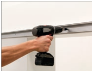
1. Mocowanie szyny jezdnej od frontu
